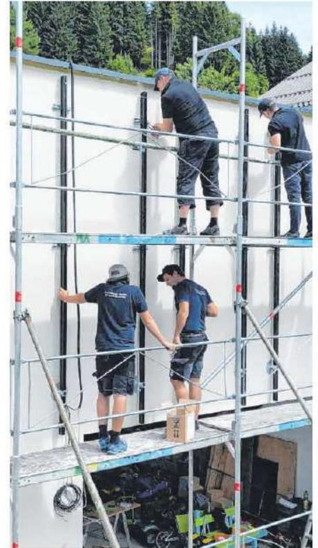
Die innovative Lösung erlaubt eine sichere und schnelle Montage der PV-Fassade. LUKAS DOBLER (2)
